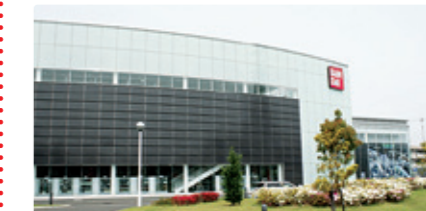
壁一面に設置された大型ソーラーパネル
